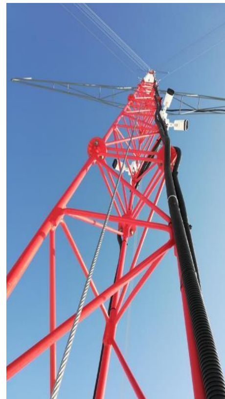
Maszt pomiarowy w Lubiatowie
