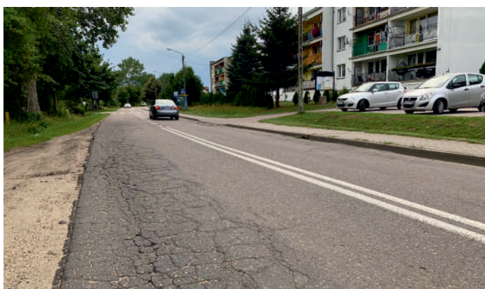
Droga powiatowa Sławoszynko - Parszczyce
