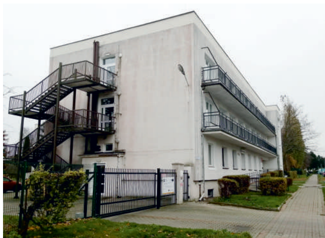
Trwają prace w Domu Pomocy Społecznej.
