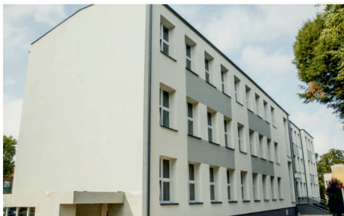
Termomodernizacja I LO w Pucku
