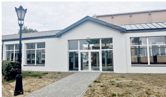
Łącznik w PCKZiU widok z zewnątrz
