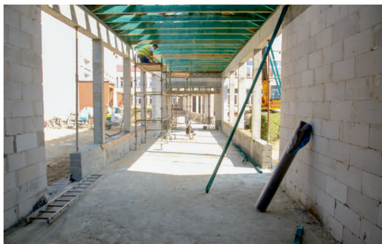
Budowa łącznika w PCKZIU w Pucku
