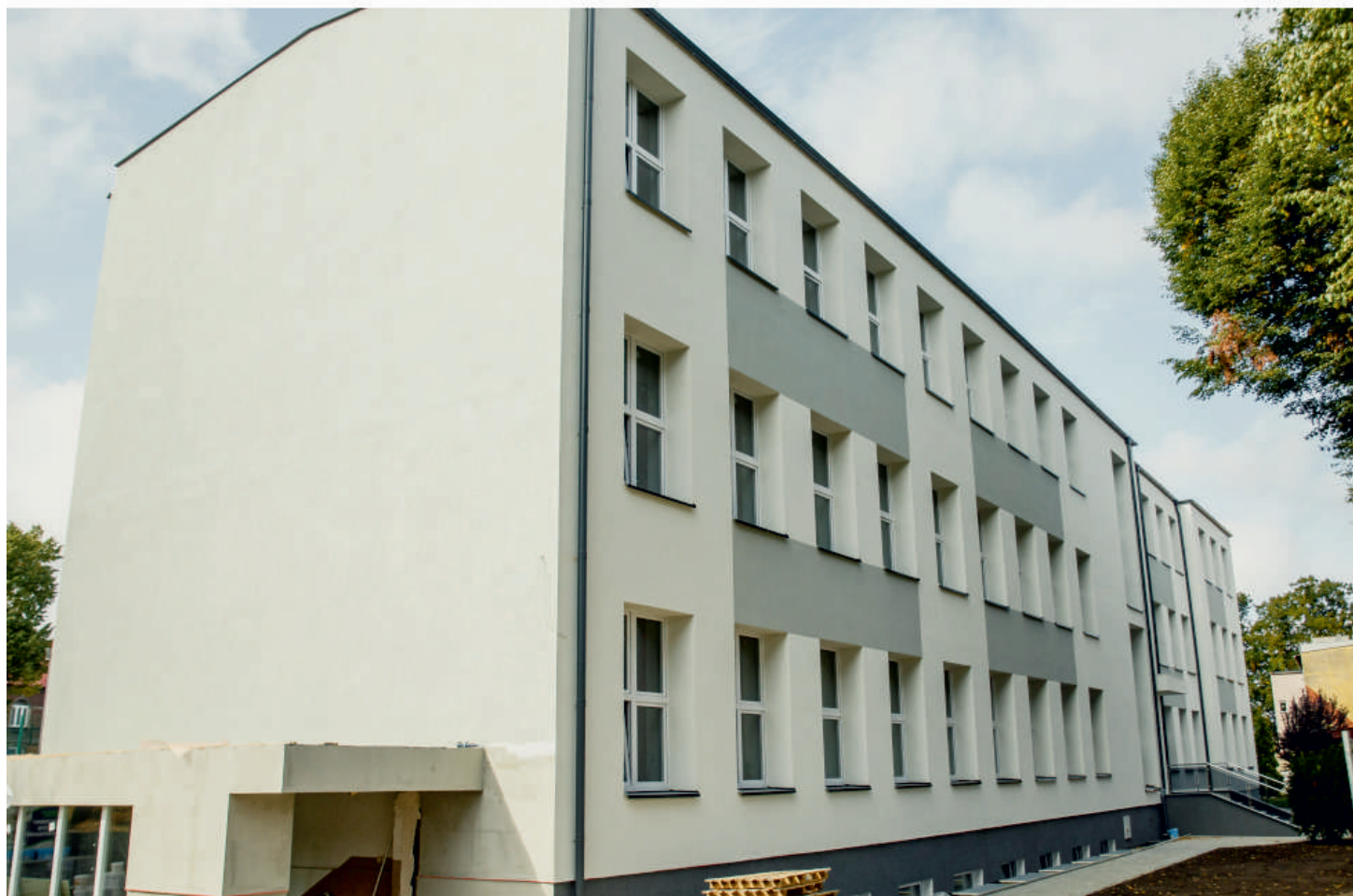
Termomodernizacja 1 LO w Pucku
