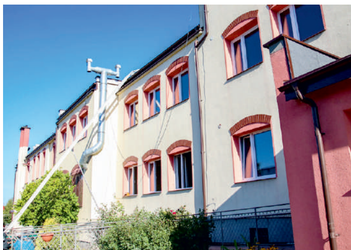
Termomodernizacja SOSW w Pucku
