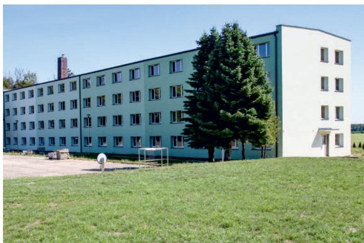
Termomodernizacja ZSP Kłanino
