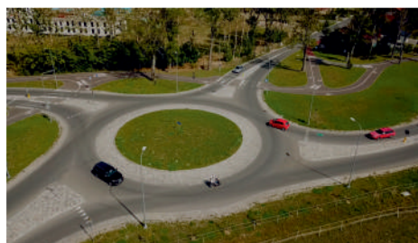
Podsumowanie inwestycji drogowych Powiatu Puckiego
